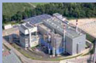
Thermal recycling plant by the AVE group in Upper Austria. Thermische Abfallverwertungsanlage der AVE Gruppe in Oberösterreich.
