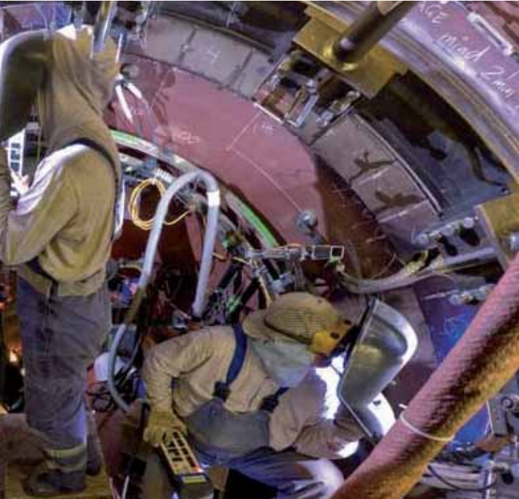
Ein Prestigeprojekt der früheren MCE: Instandsetzung der Druckschachtpanzerung für die Wasserkraftanlage Cleuson-Dixence im Schweizer Wallis.
