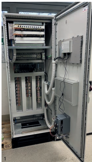
Die Möglichkeit, drei HSR-Ringe pro Switch aufzubauen, spart Platz und Materialien im Serverschrank.
