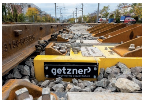
Sensor Sleepers liefern wertvolle Grundlagen, um kritische Bereiche besser zu bewerten und wirksame Maßnahmen zu treffen.
