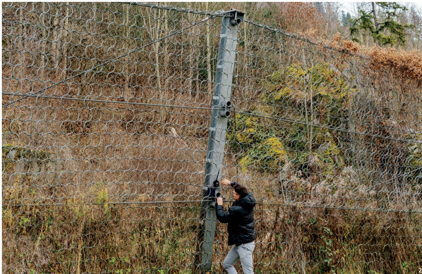
Montage eines autonomen Sensorknotens an einem Steinschlagnetz der Asfinag im Bereich St. Michael
