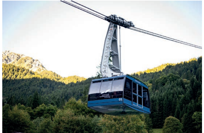
Herzstück der Erneuerung der Fellhornbahn I sind die bodentief verglasten Kabinen, die den Fahrgästen einen Rundum-Panoramablick ermöglichen.
