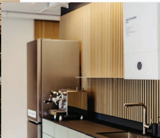
Die Soletherme ersetzt die Gastherme und bereitet Warmwasser und Heizwärme.
