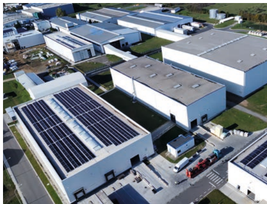
Am Neveon-Standort in Rumänien wurde eine 400 kW starke Photovoltaikanlage installiert.
