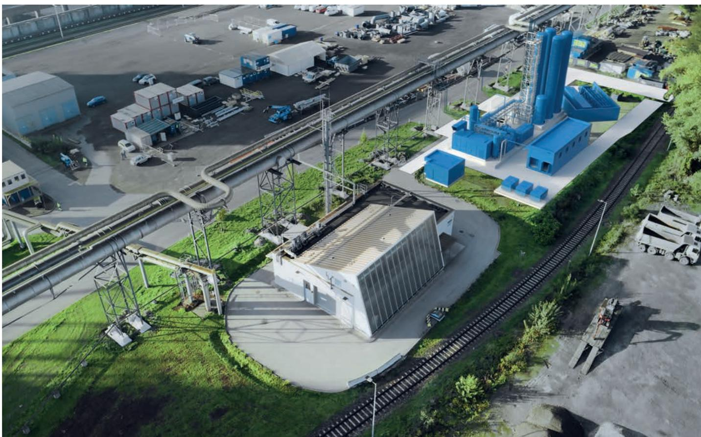
Die Erweiterung wird die Produktion, Verdichtung, Reinigung und Speicherung bis hin zur Verladung und Weiterverwendung von grünem Wasserstoff umfassen.
