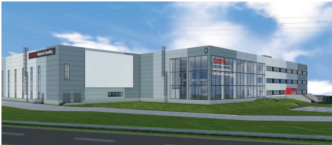
Das neue Gebäude der Toyota-Material-Handling-Austria-Firmenzentrale entsteht in Österreichs größtem Gewerbegebiet im VGP Park Laxenburg.
