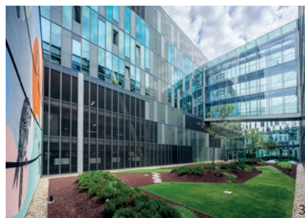
Erdschrauben durchbohrten die Abdichtung des Daches und führten zu Wassereintritten.
