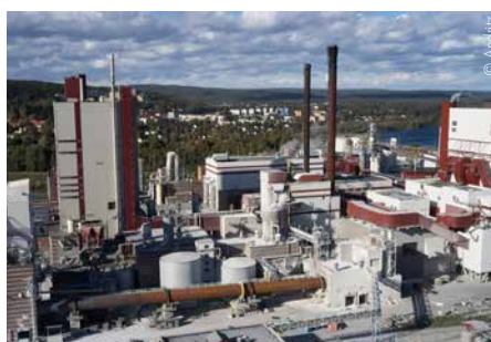
Kalkofen und Rückgewinnungskessel im SCA-Werk Östrand in Schweden.
