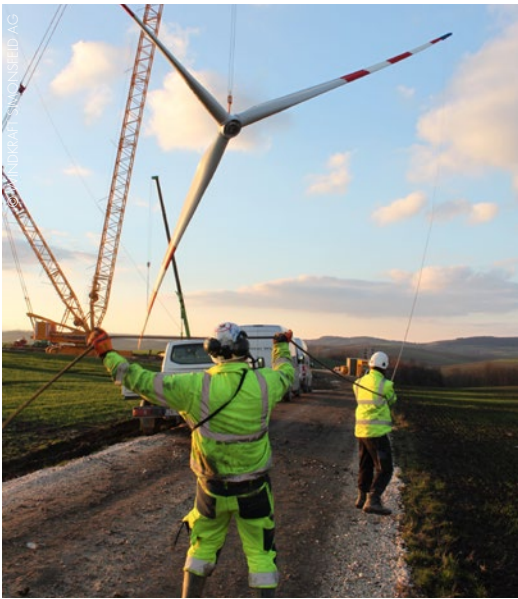
Hub des Rotorsterns bei der Montage des Windkraftwerks. Martin Steininger, Vorstand Windkraft Simonsfeld AG, freut sich über den technischen Fortschritt.
