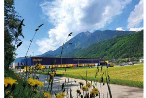
DACHSER-Logistikzentrum Tirol in Stans
