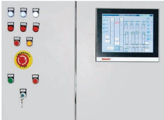
Der Embedded-PC ist mit einem Control-Panel CP2912 von Beckhoff als HMI verbunden.
