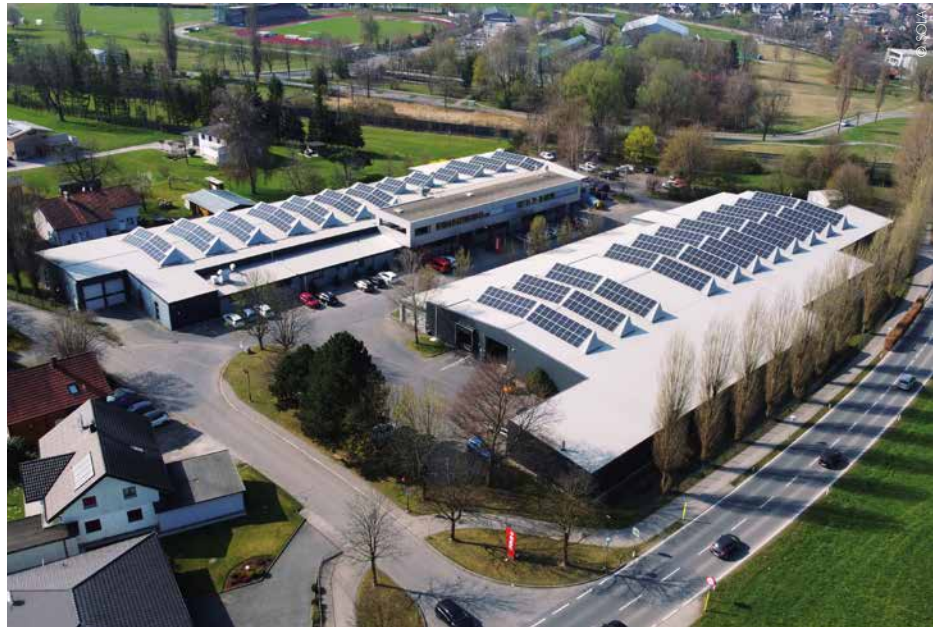
Die Photovoltaik-Aufdachanlagen an den Werken 1 und 2 in Götzis.
