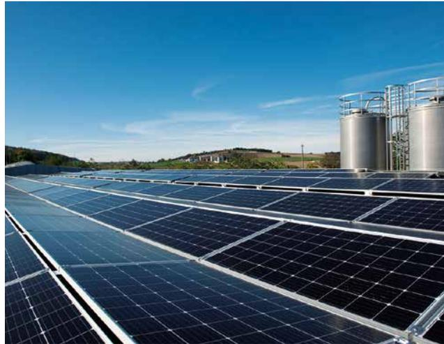
1.438 Solarzellen auf rund 3.600 m<sup>2</sup> Dachfläche decken bis zu 38 % des Strombedarfs am Produktionsstandort Würmla. Damit erspart Miraplast der Atmosphäre jedes Jahr 121 t CO<sub>2</sub>.
