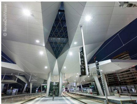
Spektakuläres Lichtspiel durch die Rautendachkonstruktion aus Stahl am neuen Wiener Hauptbahnhof.
