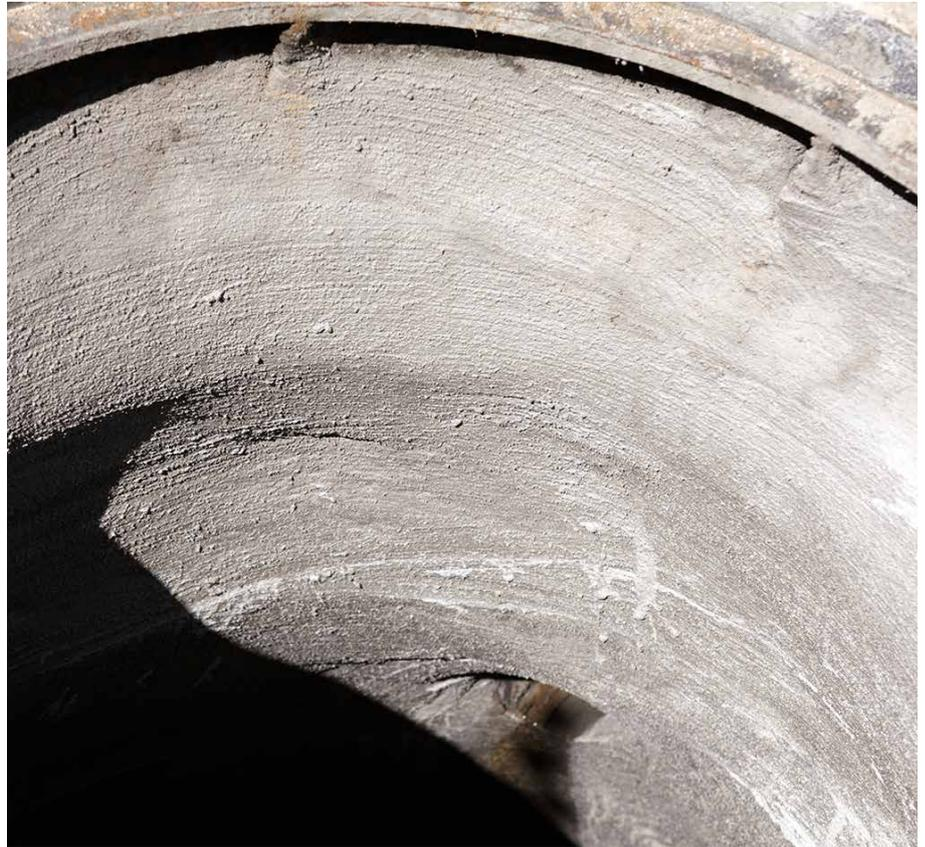
Schacht nach der Sanierung mit Vortex GeoKrete®
