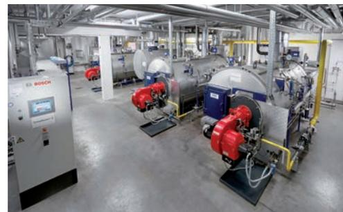
Die Dampfkessel mit neuen Zweistoffbrennern versorgen die Fleischwarenproduktion mit Dampf.
