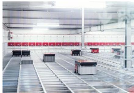
OxyReduct® senkt die Sauerstoffkonzentration im Schutzbereich des AutoStore-Lagers dauerhaft auf ein entsprechendes Schutzniveau.
