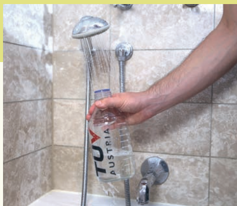
Alltägliche Infrastrukturelemente wie Duschen, Klima- und Warmwasseranlagen begünstigen das Aufkeimen von Legionellen.
