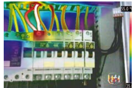
Thermografie: Die Messungen zeigen, wo Wärme verloren geht.
