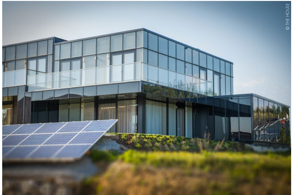
Das Wohnhaus wird durch einfache Physik zum ökologischen Kraftwerk, zum Plusenergiehaus.
